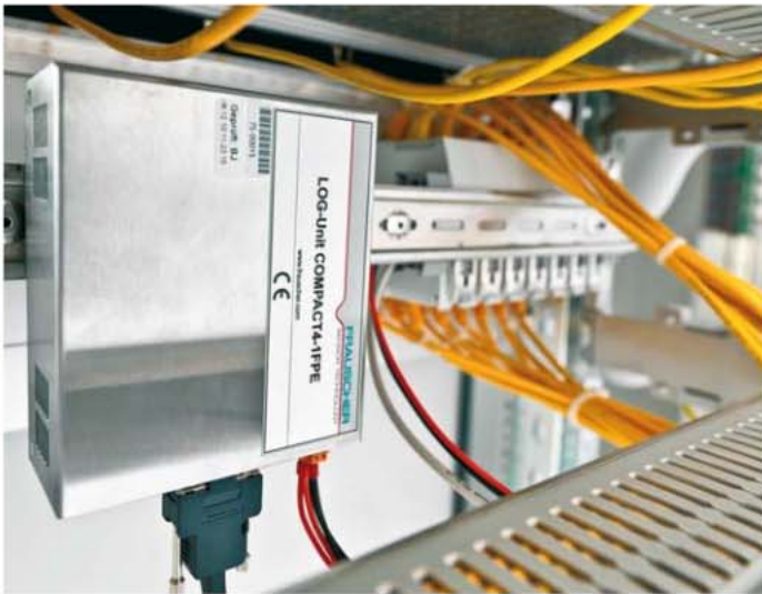
In sämtlichen Achszählssystemen werden die Rechner von Syslogic zur Steuerung der Diagnosesysteme verwendet.
